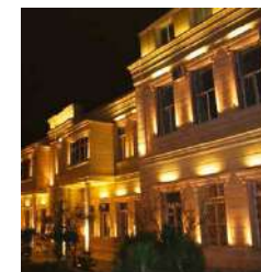
Voorbeeld van gevelverlichting
