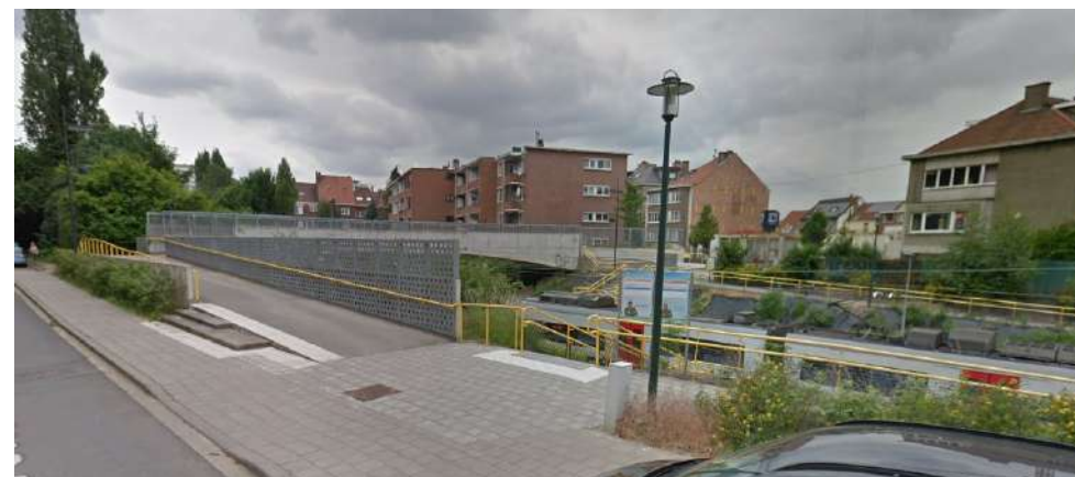
Recente bouw van een brug voor zachte verplaatsingswijzen in Evere, tussen de Jean Brussel-manslaan en de Louis Piérardlaan (toegankelijk voor PBM)
