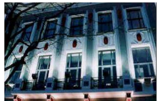
Voorbeeld van een gevelverlichting
