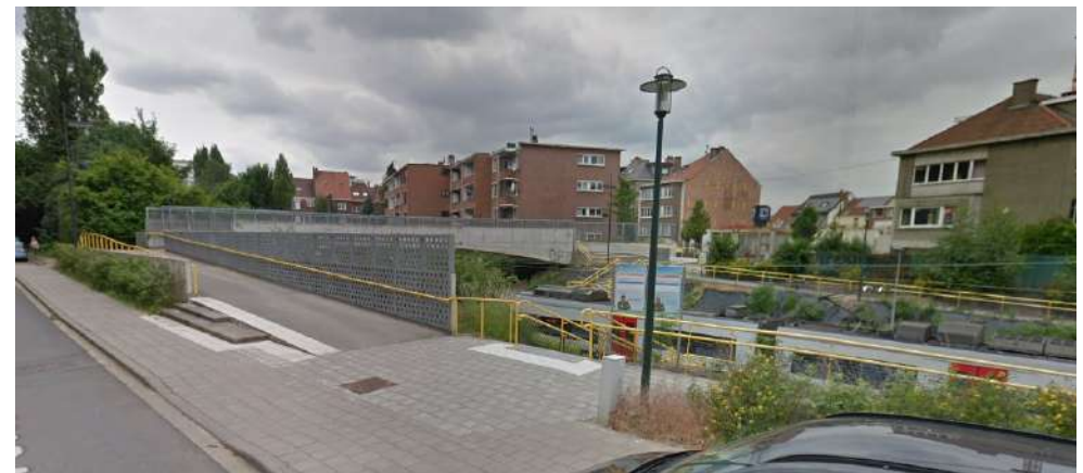
Aménagement récent d'une passerelle modes doux à Evere, entre les avenues Jean Brusselmans et Louis Piérard (accessible PMR)
