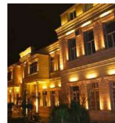
Exemple d'éclairage sur façade
