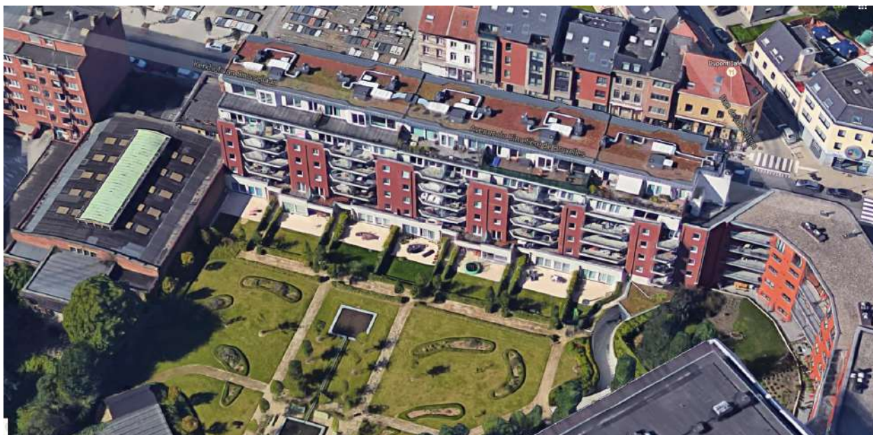
Toiture verte sur le nouvel immeuble de logement avenue du Cimetière de Bruxelles (source googlemaps 3d)
