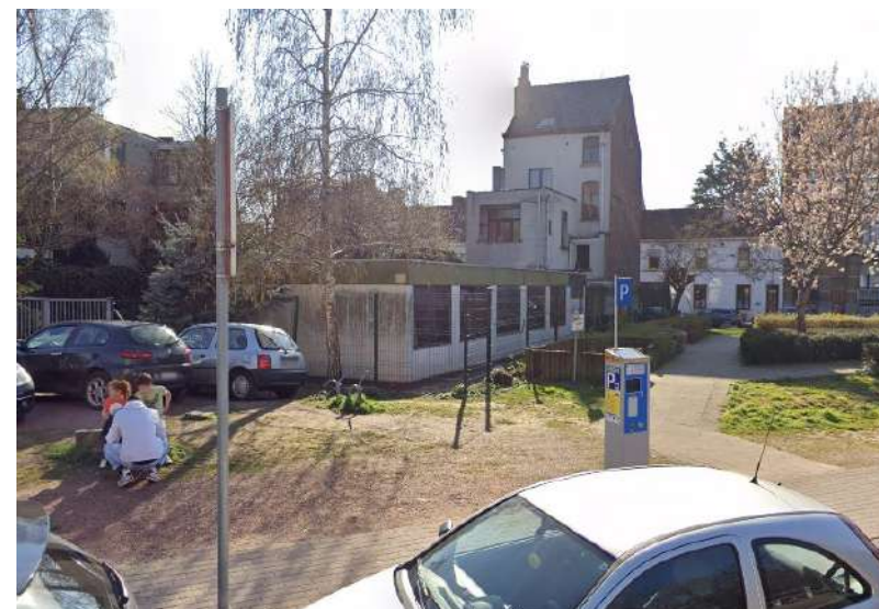
Réfectoire préfabriqué de l'école communale Clair Vivre (source : Google street View)
