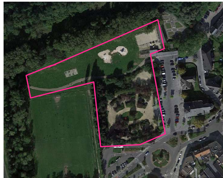
Réaménagement de la zone de loisir entre la place Saint-Vincent et le Moeraske
