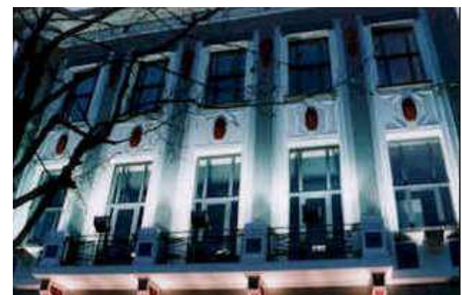
Exemple éclairage sur une façade
